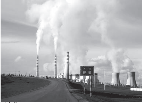
写真⑤： 草原の中に建つイミン（伊敏）炭鉱併設の火力発電所
